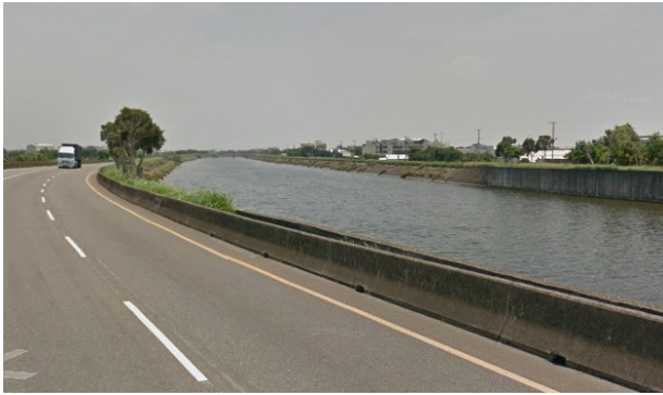
員林大排水域現況及植生情形
