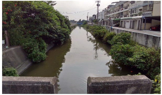
橋台二排水域現況及植生情形
