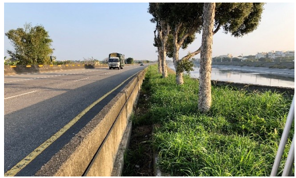
員林大排河岸堤防及道路現況
